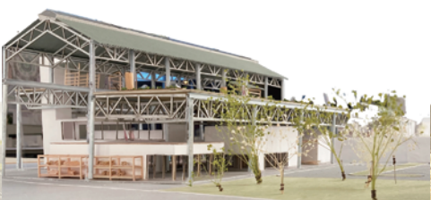
西側の車道から見る
