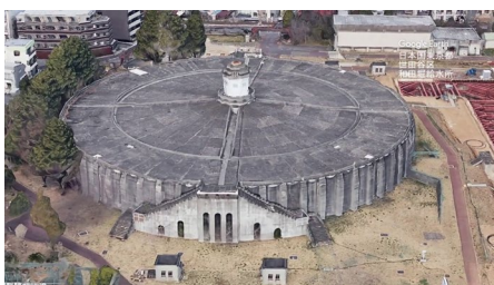
現在の和田堀給水所の様子
