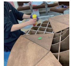
⑤木工用ボンドを用いて 天板をベンチ本体に取り付ける
