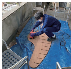
②ベルトサンダーを用いた 表面の研磨
